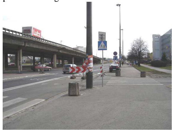
Fot. 19. Wlot ul. Modlińskiej – widoczne nieprawidłowe oznakowanie przejścia dla pieszych. Proponowane przesunięcie znaku D-6 przed przejście dla pieszych
