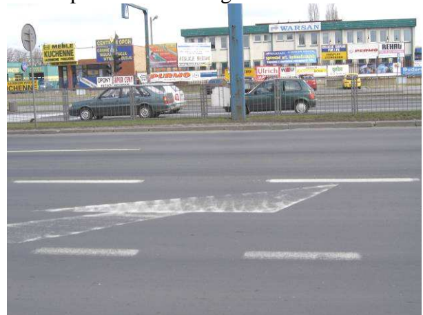
Fot.2 i fot. 3. Ul. Modlińska – widoczne nieczytelne i wymagające poprawy oznakowanie poziome pasa autobusowego.
