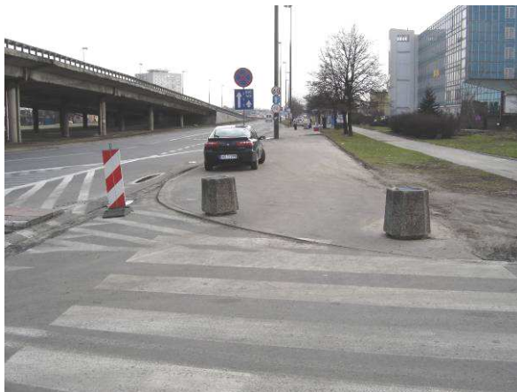
Fot. 18. Wlot ul. Familijnej. Widoczne prowizoryczne (z wykorzystaniem koszy na śmieci) zabezpieczenie przed omijaniem przez samochody powierzchni wyłączonej z ruchu
