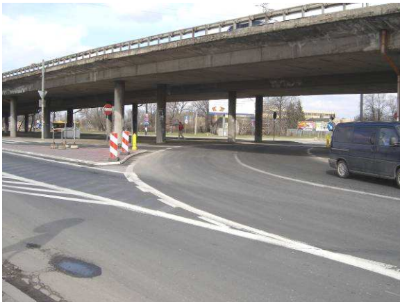
Fot. 14. Skrzyżowanie ul. Modlińskiej z Płochocińską. Widok na pas, który proponuje się przeznaczyć dla ruchu autobusowego z zastosowaniem separatora od połowy długości łuku wyznaczającego to skrętu.
