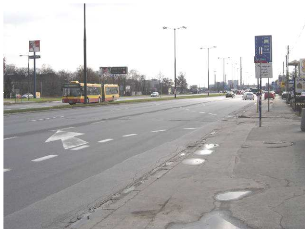
Fot. 4. Ul. Modlińska. Widoczny pas włączeń dla pojazdów wyjeżdżających z Obrazkowej oraz strzałki naprowadzające pomiędzy które należy wprowadzić napis BUS
