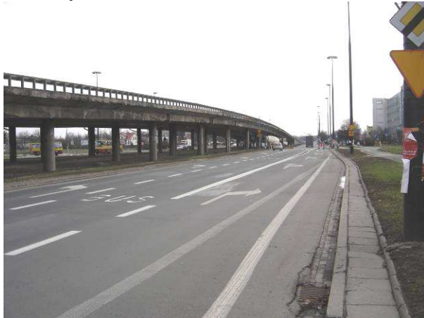
Fot. 12. Widok na wlot ul. Modlińskiej na skrzyżowaniu z ul. Płochocińską oraz prawą krawędź jezdni wzdłuż której zaleca się wydzielenie drogi rowerowej.
