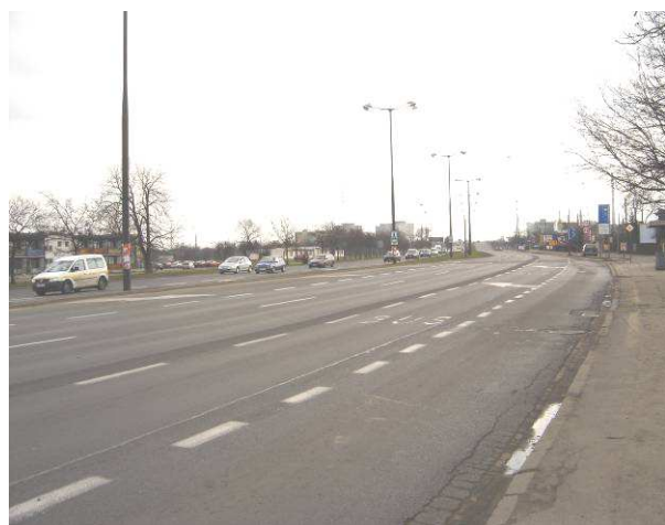
Fot. 7. Ul. Modlińska, odcinek Płużnicka-Przaśna – wskazane wprowadzenie oznakowania poziomego BUS na prawym skrajnym pasie ruchu.
