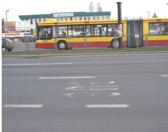
Fot. 5. Ul. Modlińska – widoczne niskiej jakości oznakowanie poziome pomiędzy ul. Obrazkową a Życzliwą.
