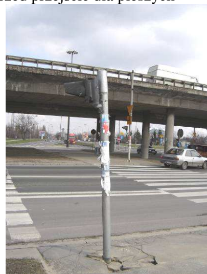
Fot. 20 i 21. Wlot ul. Modlińskiej. Widoczny sygnalizator, którego posadowienie wymaga naprawy
