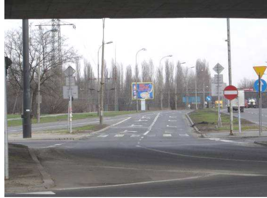
Fot. 17. Wlot ul. Płochocińskiej, widok na dwa pasy wydzielone do skrętu w lewo w kierunku centrum. Zalecane ograniczenie do jednego liczby pasów ruchu do skrętu w lewo i pełne wydzielenie pasa przeznaczonego dla autobusów.
