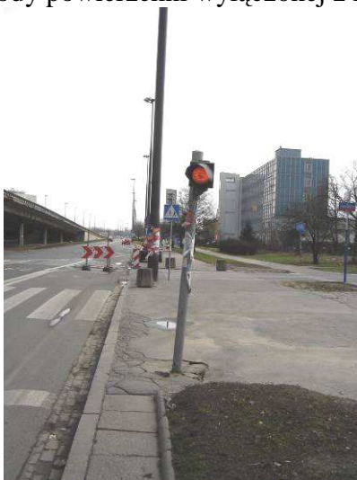
Fot. 20 i 21. Wlot ul. Modlińskiej. Widoczny sygnalizator, którego posadowienie wymaga naprawy
