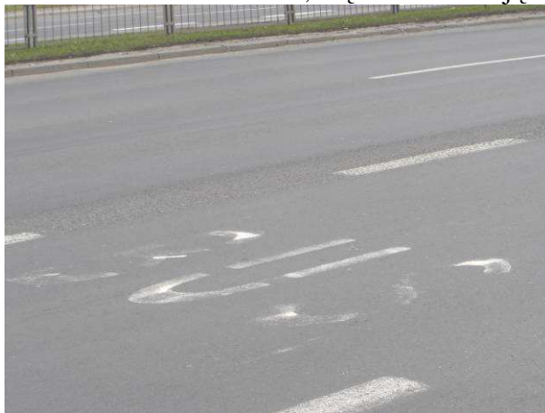
Fot.2 i fot. 3. Ul. Modlińska – widoczne nieczytelne i wymagające poprawy oznakowanie poziome pasa autobusowego.
