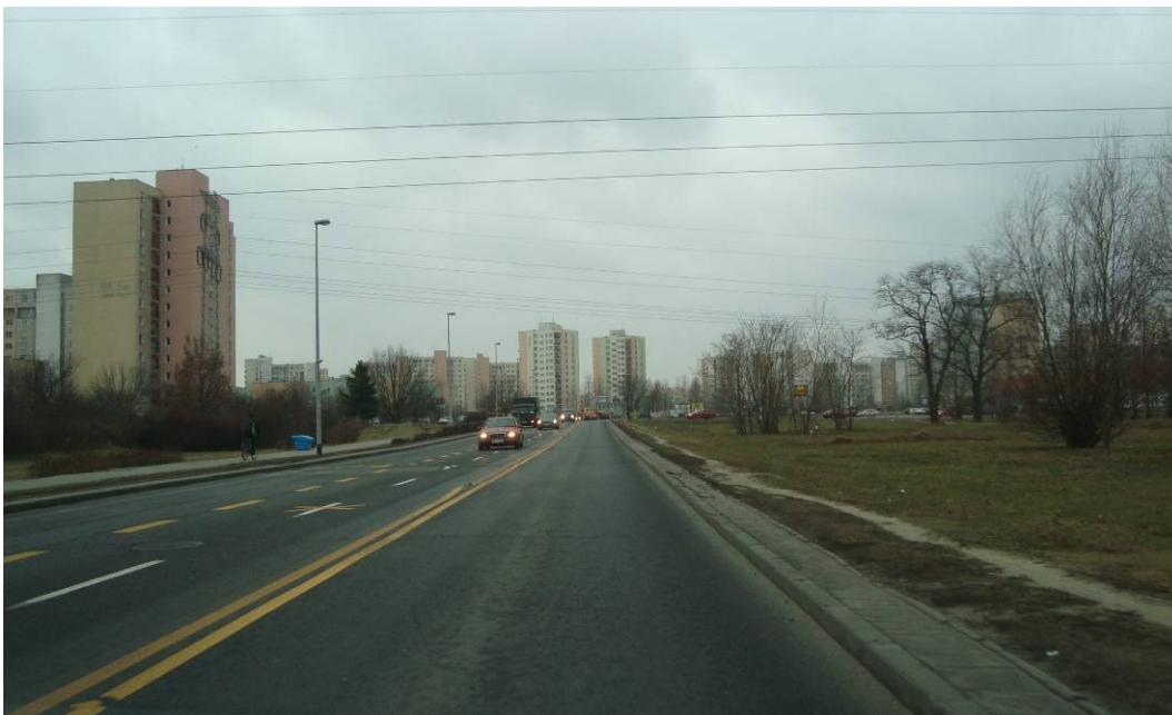
Fot. 4.8. Stan istniejący – brak chodnika
