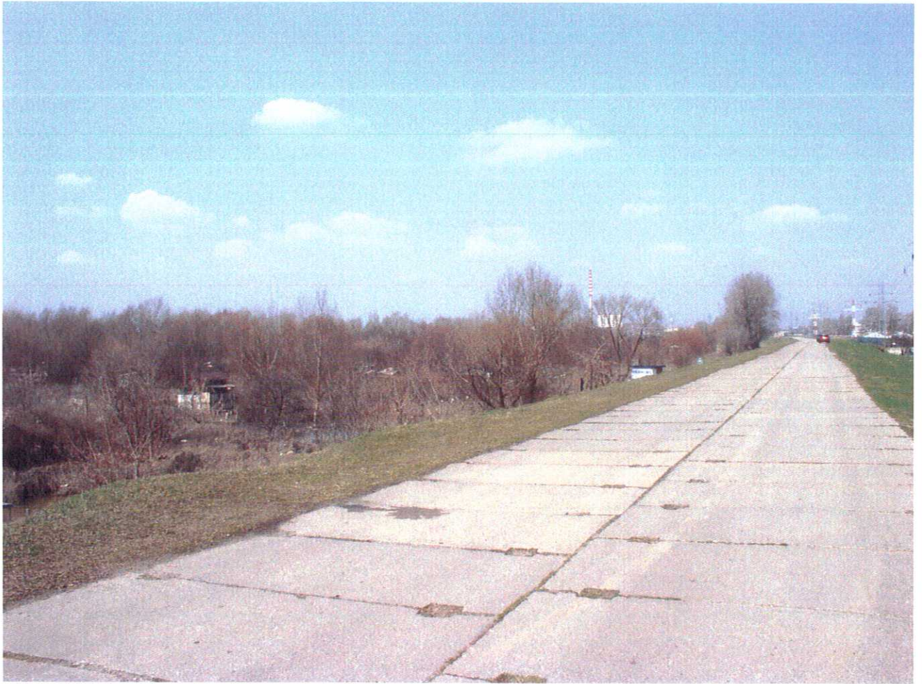
Wiz. 3. A. Widok w kierunku północnym wzdłuż wału przeciwpowodziowego na wysokości FSO. Stan istniejący.
