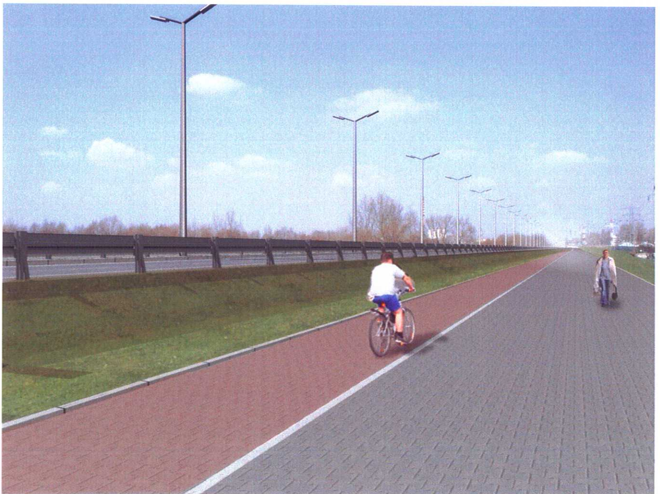
Wiz. 2. B. Widok w kierunku północnym wzdłuż wału przeciwpowodziowego na wysokości FSO. Projekt. Wariant 1.
