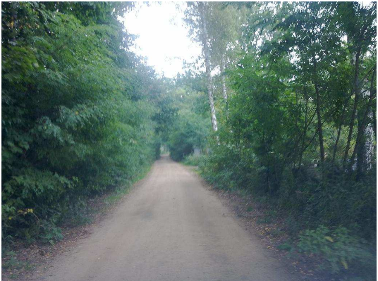
Gałęzie drzew zawężające szerokość drogi gruntowej – ul. Grudowskiej
