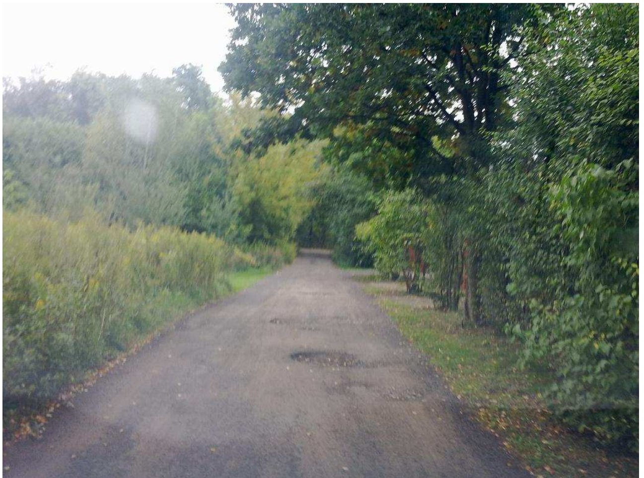
Widoczne dziury w nawierzchni ul. Grudowskiej
