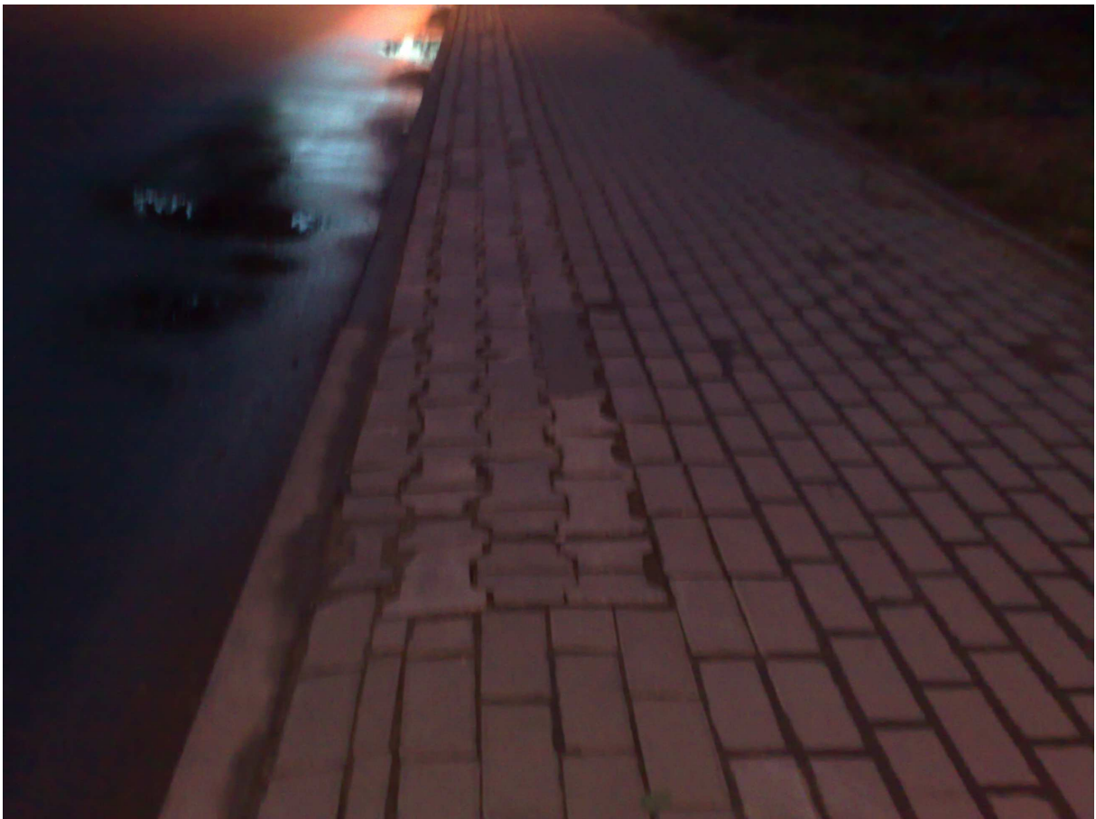
e) uzupełnienie niechlujnie wykonane innym rodzajem kostki w chodniku (po wschodniej stronie ul. Fletniowej, za skrzyżowaniem z Kiersnowskiego),
