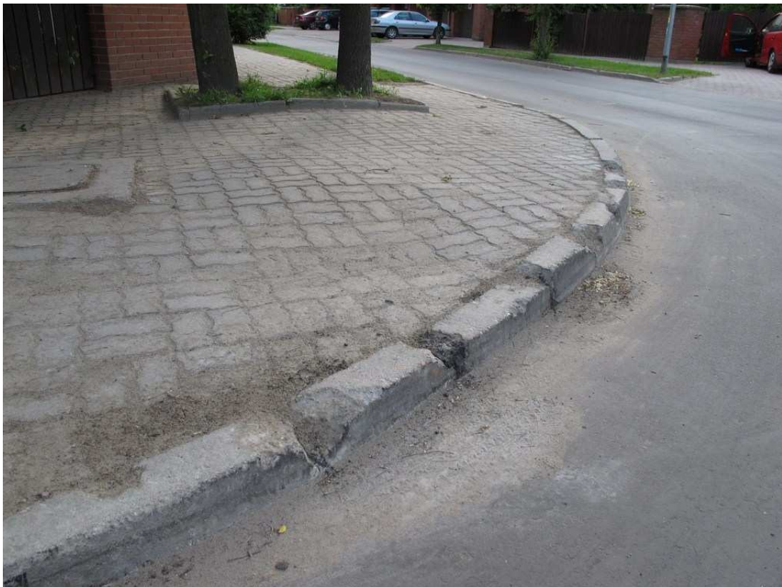
d) pozostawione silne uszkodzenia krawężnika na skłęcie (skrzyżowanie Kiersnowskiego / Fletniowa),
